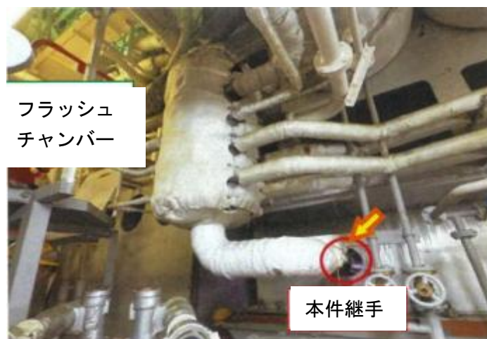
写真 1 本件継手取付状況
