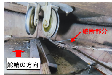
滑車部分（船底部）
