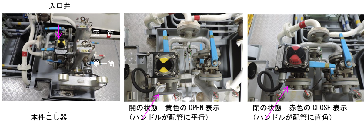
図4 本件こし器入口弁の開閉状態
