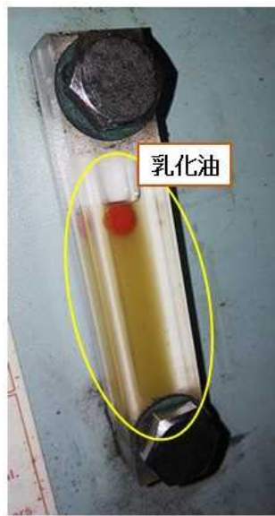
写真2 本件タンクの液面計
