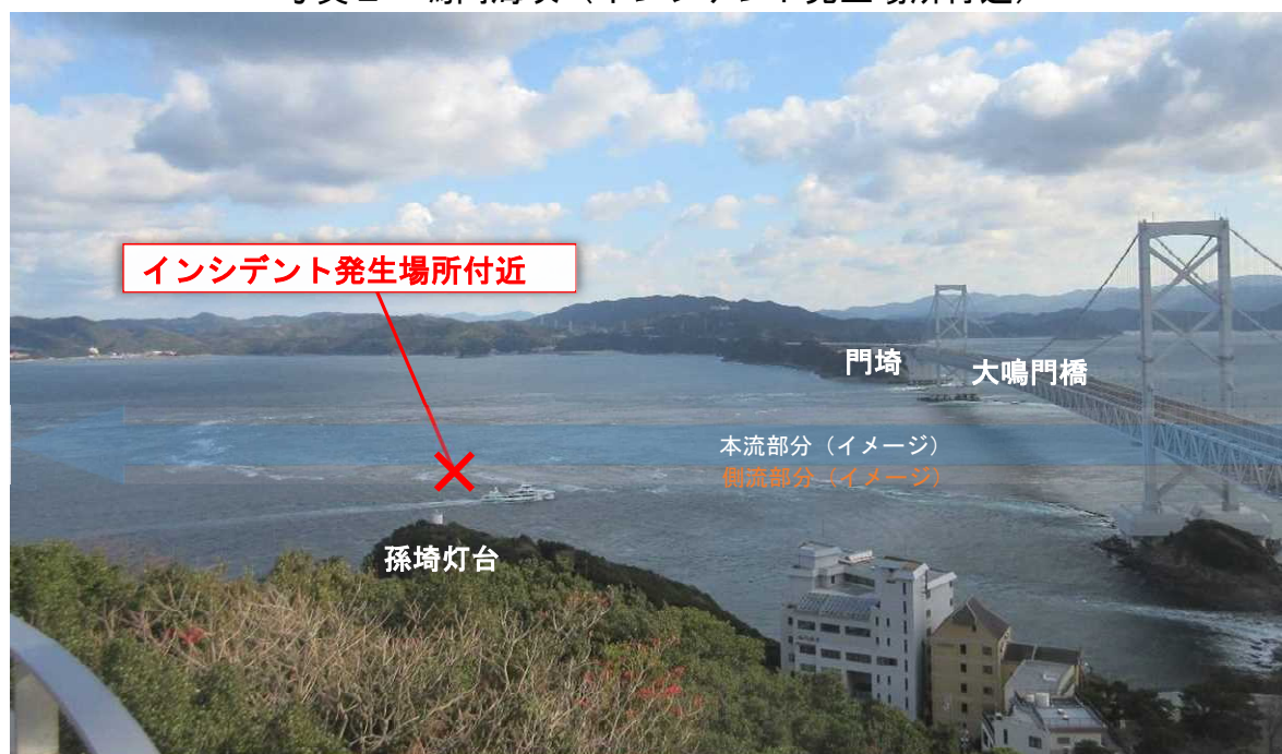
写真2 鳴門海峡（インシデント発生場所付近）
