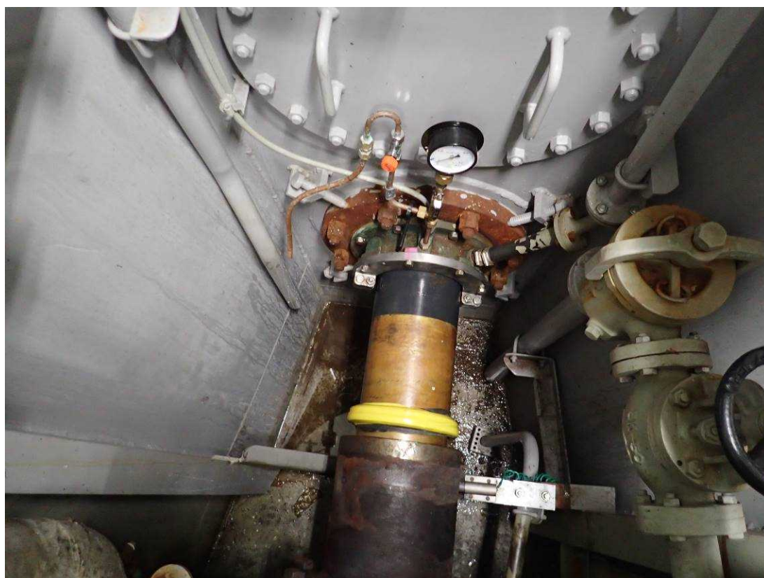
写真4 軸封装置
