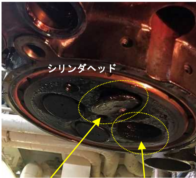
写真2 シリンダヘッド破損状況
