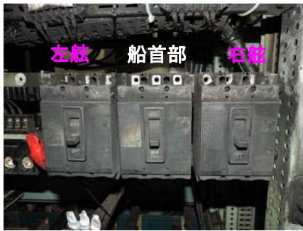
冷凍車用レセプタクルMCCB 本文(1)-1に対応
