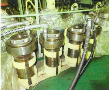
写真6 油圧ジャッキ等 (4組)
