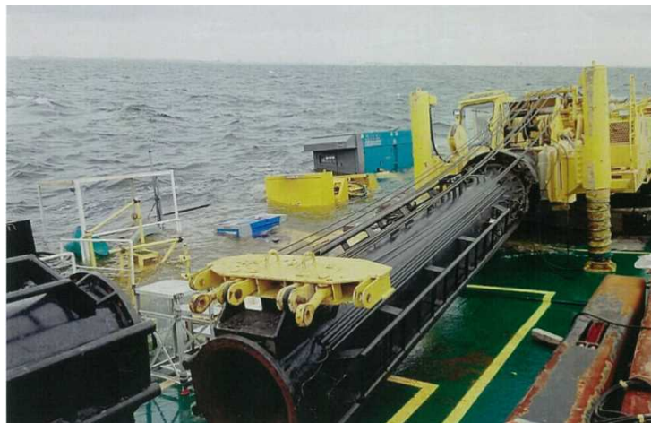
写真1 積載物水没前のB船の状況 (作業員撮影)
