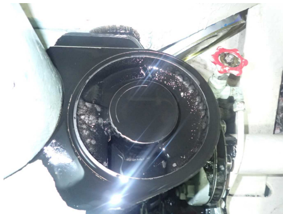
写真5 潤滑油こし器周辺の状況
