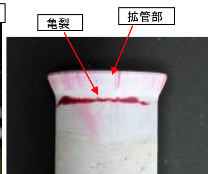
写真2 本件接続部の染色浸透探傷検査の状況
