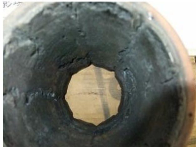
写真 1 本件軸受焼損状況
