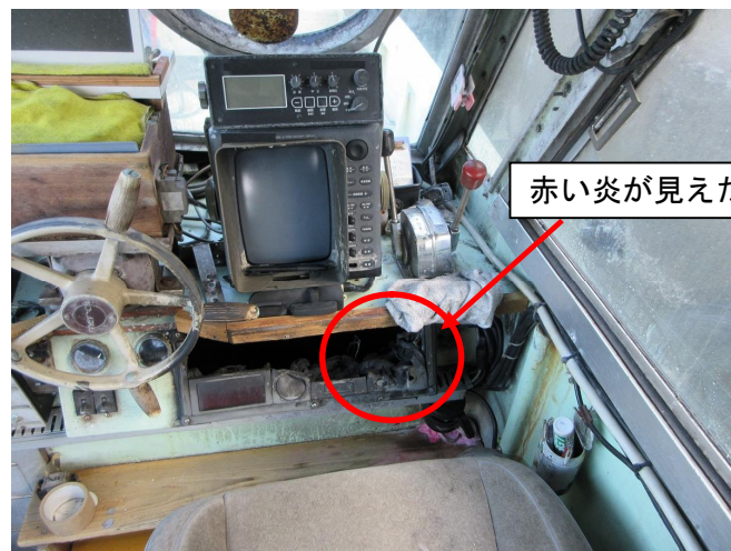
写真2 操舵室の状況（消火後）
