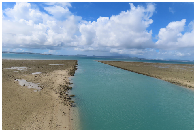
写真1 本件水路（世開橋から金武湾側を撮影）
