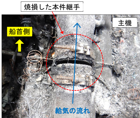
写真9 焼損した本件継手
