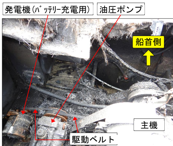
写真11 発電機(バッテリー充電用)及び油圧ポンプ
