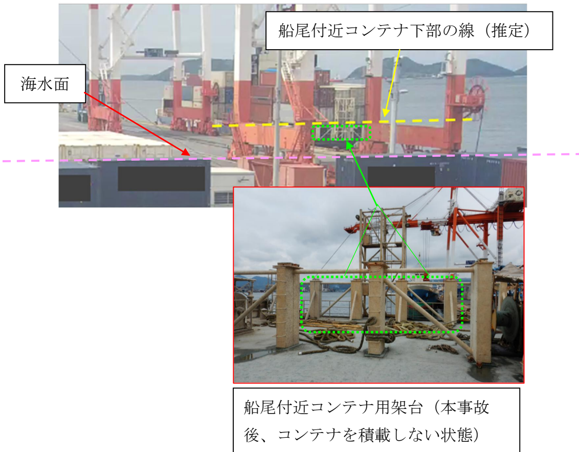
写真1 10時47分頃の本船の状況（E社提供）及び船尾付近コンテナ用架台
