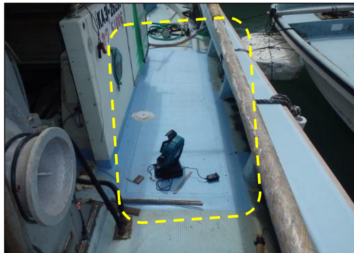
写真9 右舷修理箇所（拡大）
