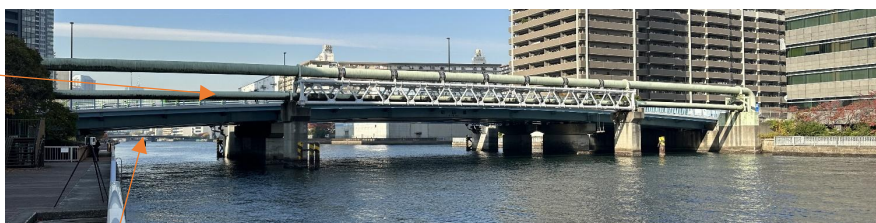
豊洲橋 写真10 朝凧橋（南方から見る）
