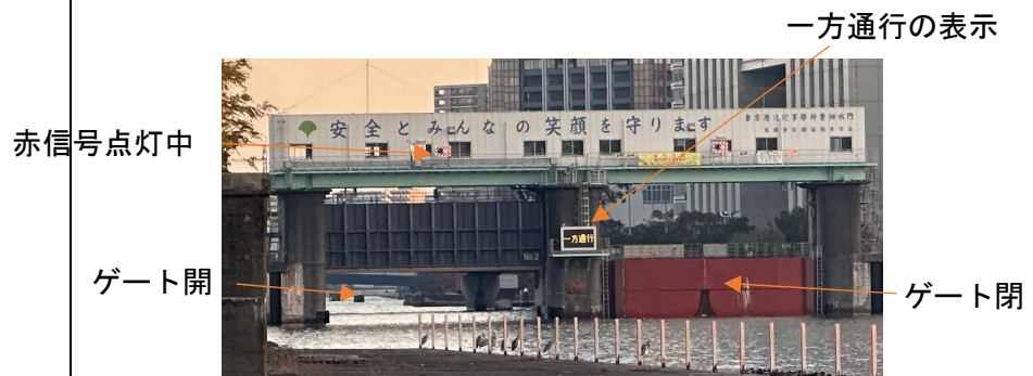
写真8 豊洲水門（北西方から見る）
