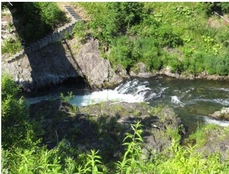
写真7 渡月橋の落ち込み（空知川左岸から撮影）
