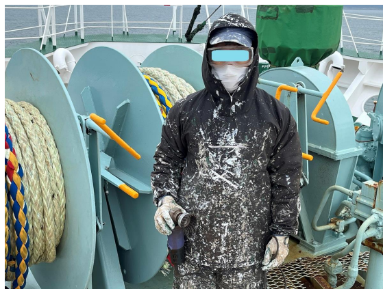
写真2 錆打ち時の保護具の装着状況(再現)
