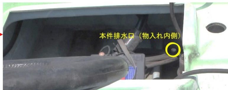
写真7 船尾部右舷物入れ部
