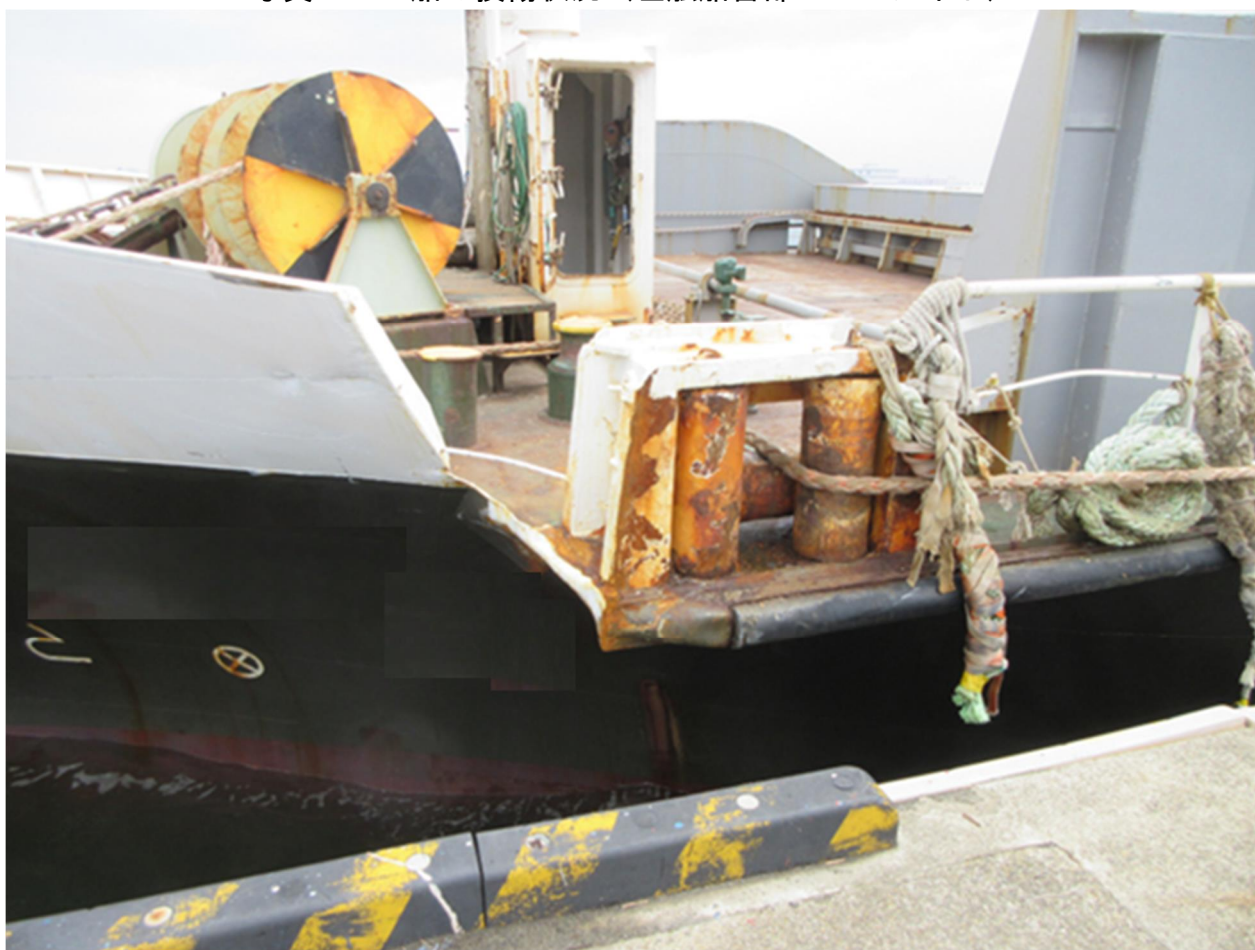
写真5 B船の損傷状況（左舷船首部ロープガイド）
