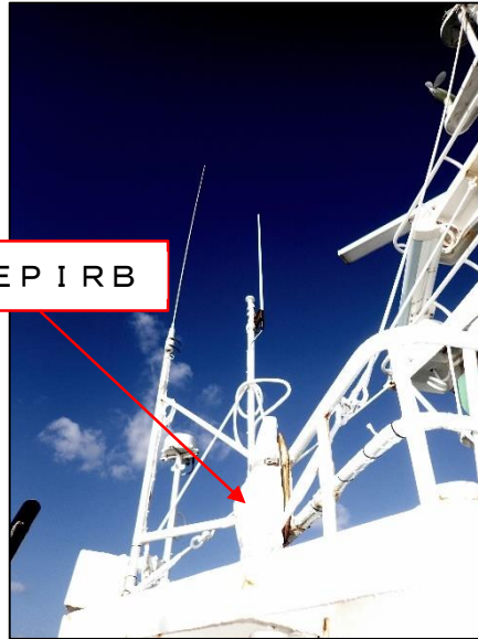
写真5 本船のEPIRBの設置状況 (GMDSS救命設備整備会社提供、整備実施時(平成31年1月21日)撮影)
