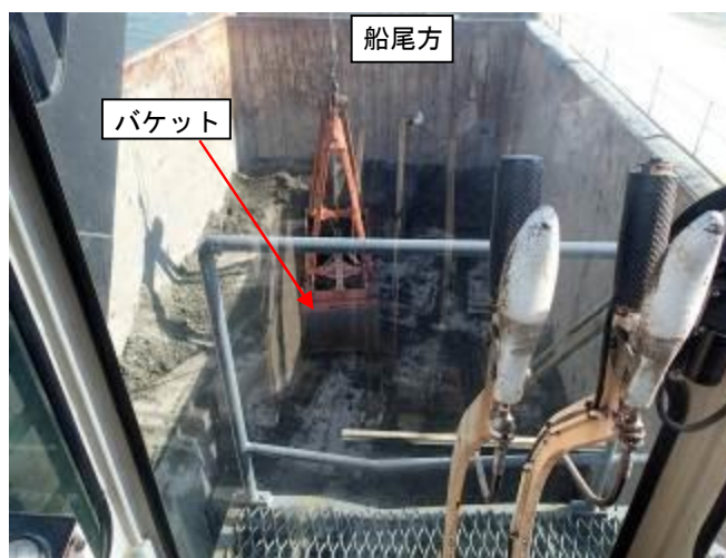
写真5 クレーン操縦席からの船倉の視認状況
