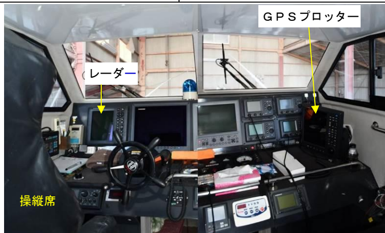
写真8 操舵室の状況
