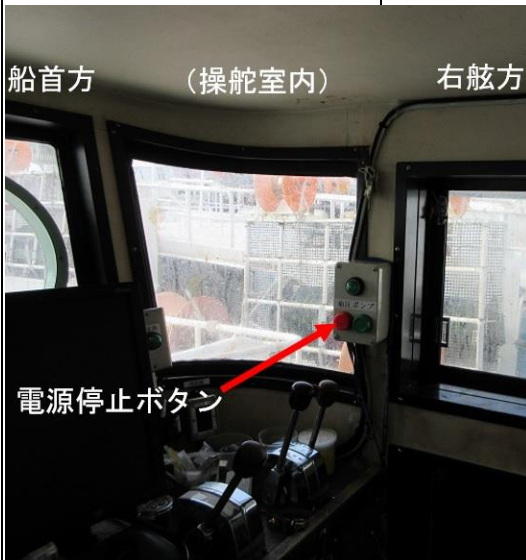
写真3 油圧ポンプの電源停止ボタン
