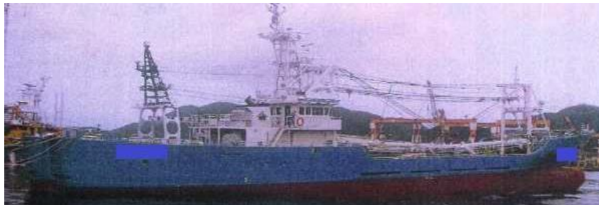
写真3 B船の右舷外板の損傷状況
