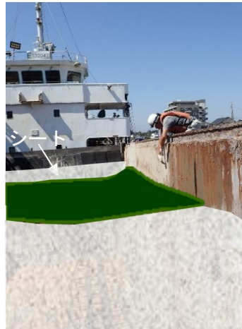
写真3 船倉内の砂上のシートを回収する状況
