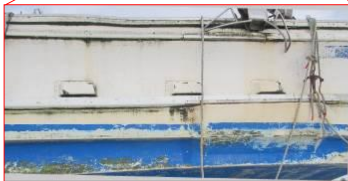
写真 1 現場調査時における放水口の状況（左舷側から撮影）
