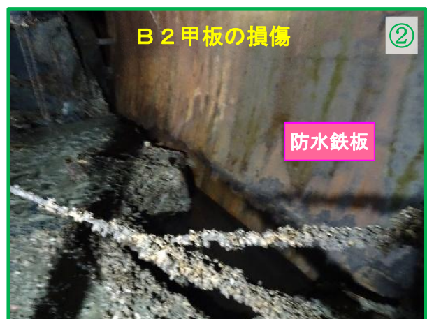
図 1 7 A船の甲板の損傷状況
