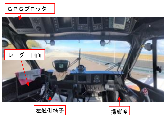
写真5 航海計器類の設置状況
