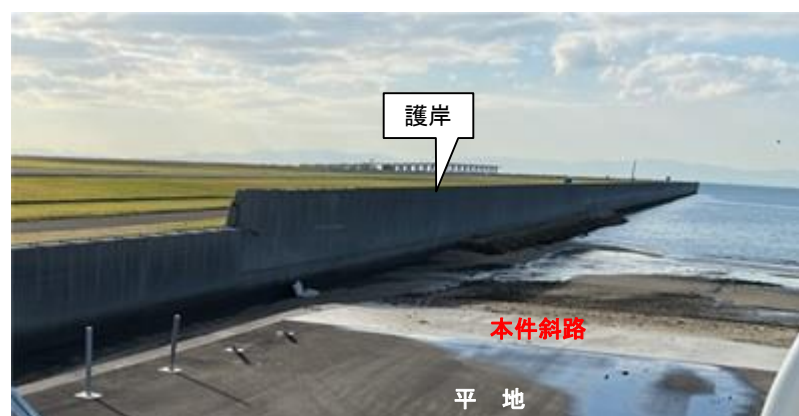
写真 4 南方に延びる護岸及び本件斜路
