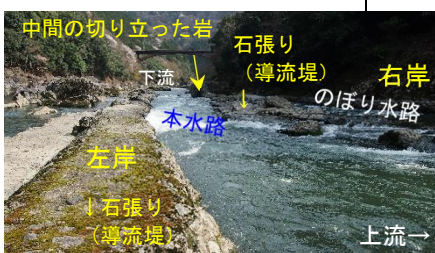
写真2 大高瀬の状況 （上流から下流を望む）
