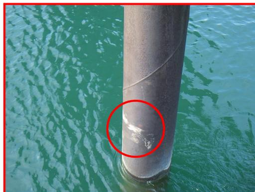
写真3 本件橋及び本件橋脚（損傷箇所）
