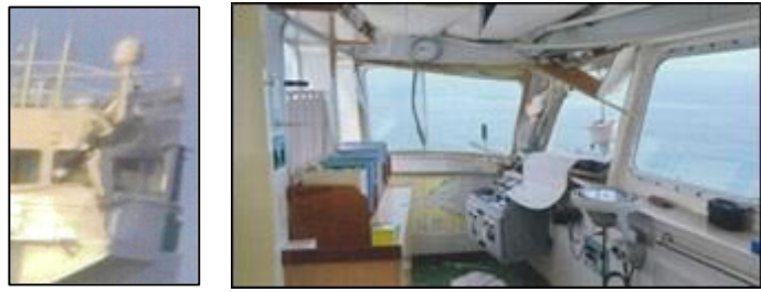
左舷ウイング損傷
