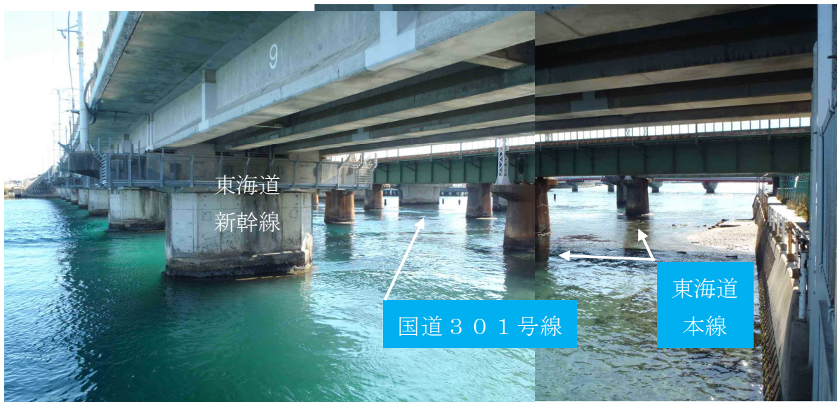
写真9 橋梁群上流西側から見た橋梁下部の状況
