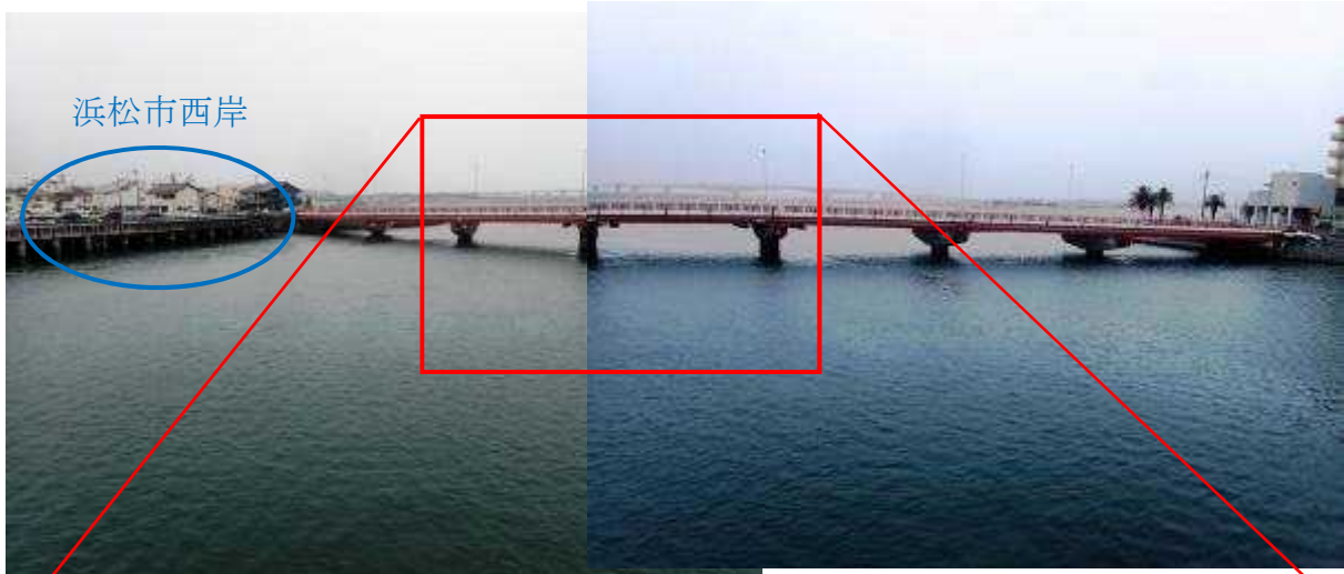
写真 1 1 弁天大橋から見た弁天橋
