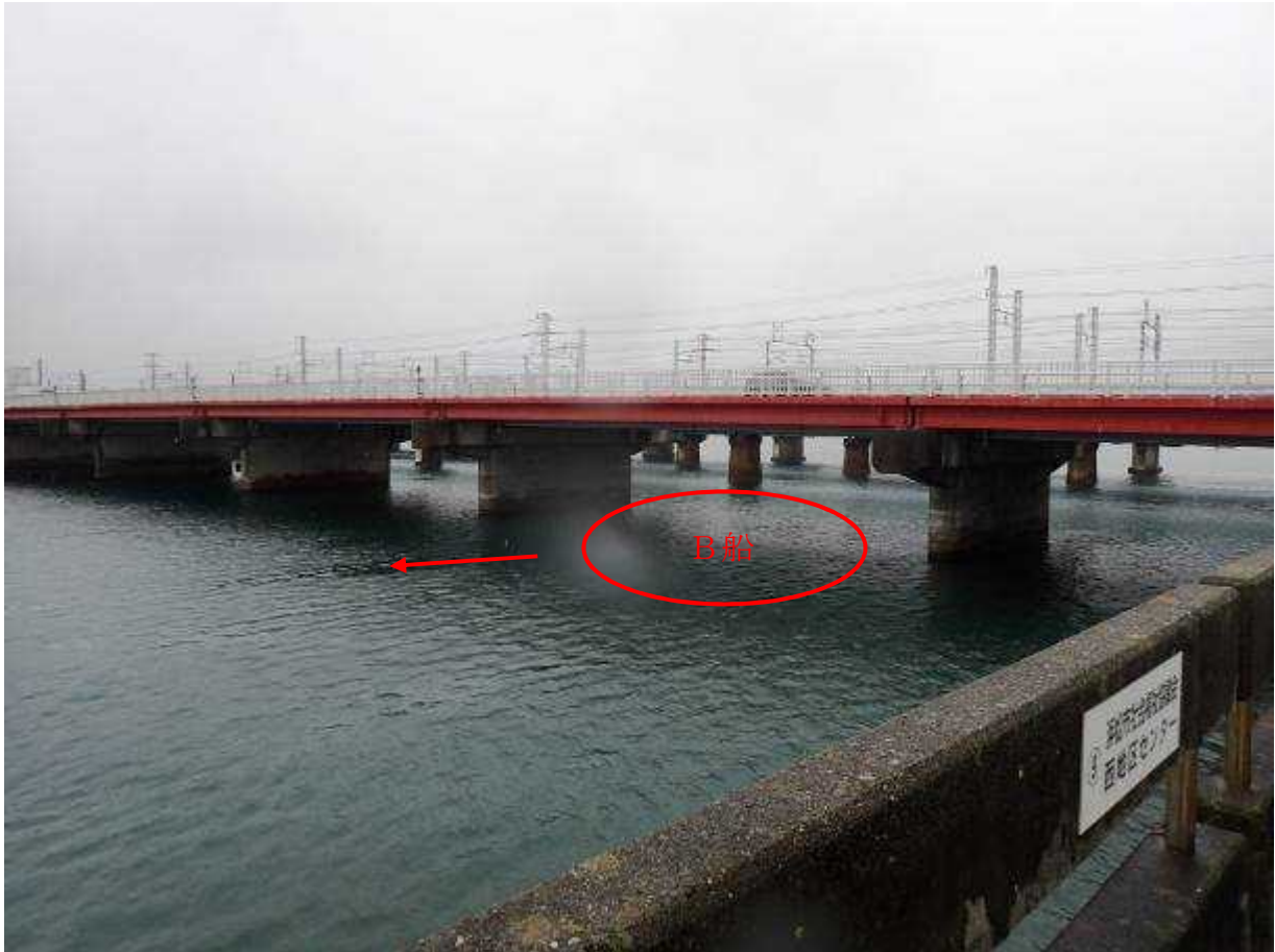
写真10 橋梁群下流東側から見た橋梁下部の状況（B船の発進場所付近）
