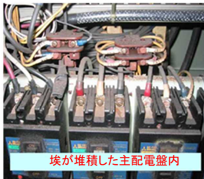
図6 埃等が電機機器内において付着した事例
