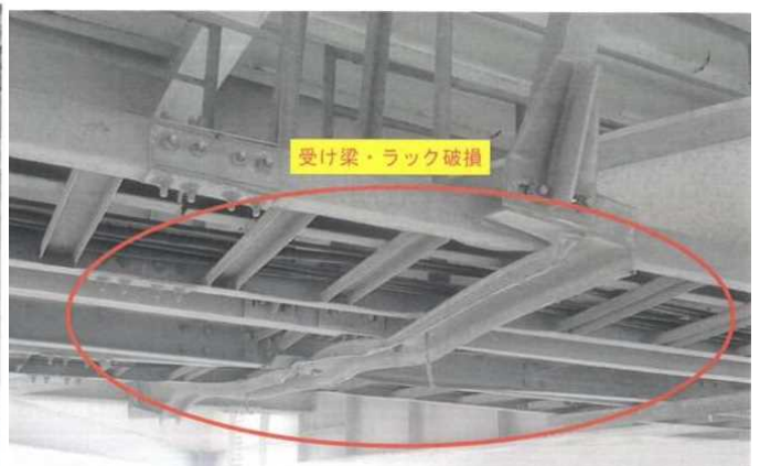
写真4 本件橋梁損傷箇所2
