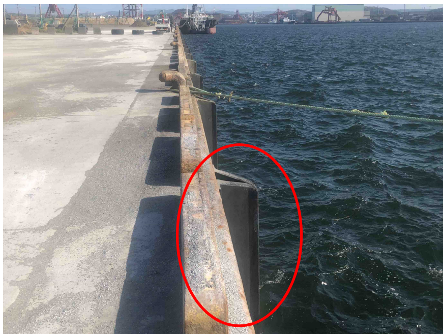
写真8 公共ふ頭E岸壁のフェンダー設置状況
