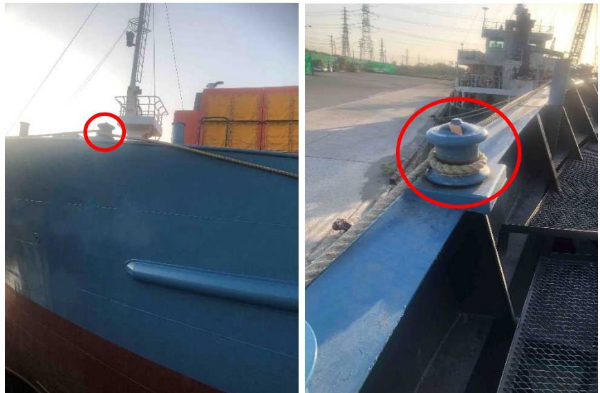
写真5、写真6 船首スプリングラインのふだんの使用状況
