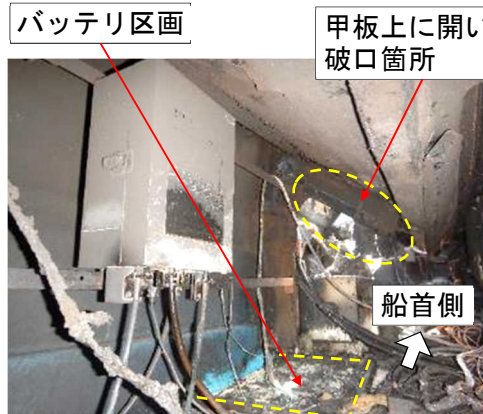
写真5 機関室左舷側の状況
