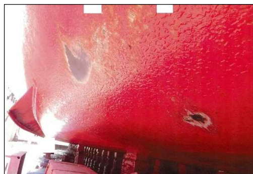
写真4 船底外板の擦過傷
