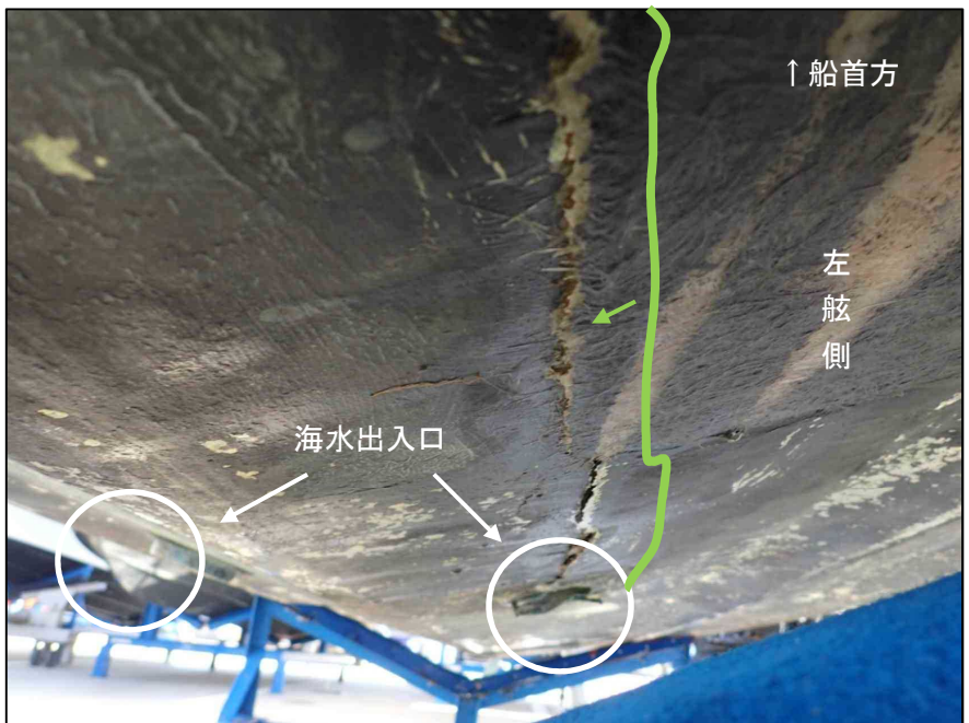
写真5 船底外板の状況
