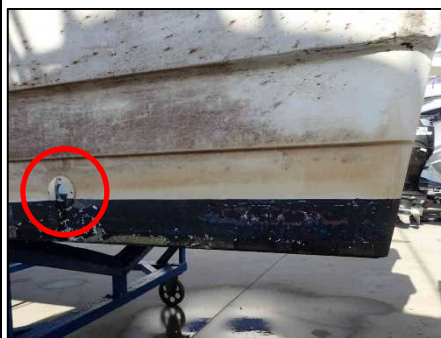
写真2 水抜き孔(左舷外側)
