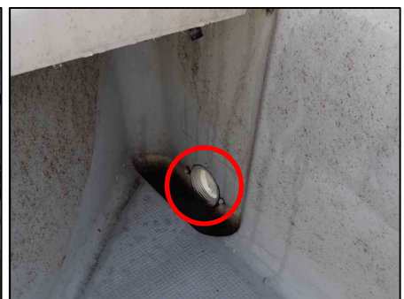
写真3 水抜き孔(左舷内側)
