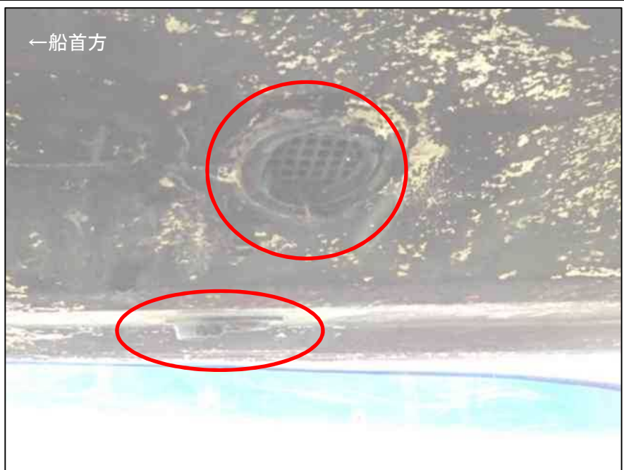
写真6 生けすの海水出入口の状況
