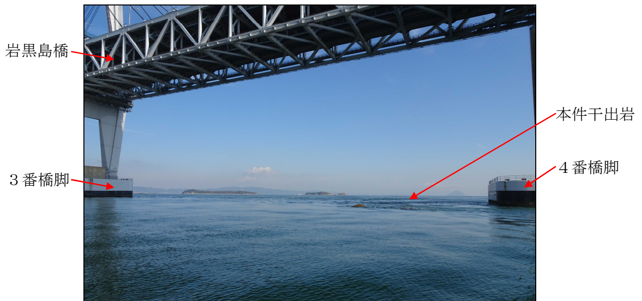
写真12 本件橋脚間（瀬戸大橋の西側から東側を見る） （撮影日時：令和2年12月11日11時30分ごろ、潮汐：下げ潮中央期で約176cm）
