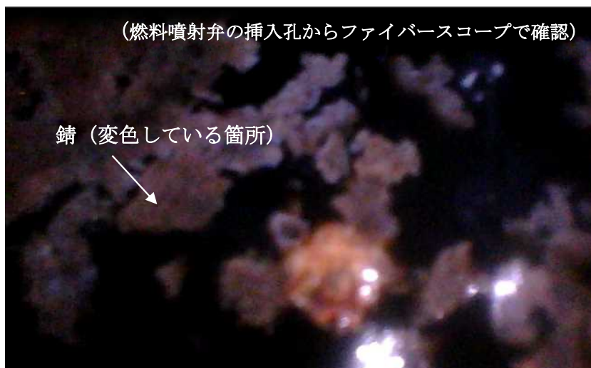
写真 2 6 主機関シリンダ内部
