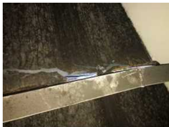
写真2.3-4 左舷船首部外板の破口(内側)
