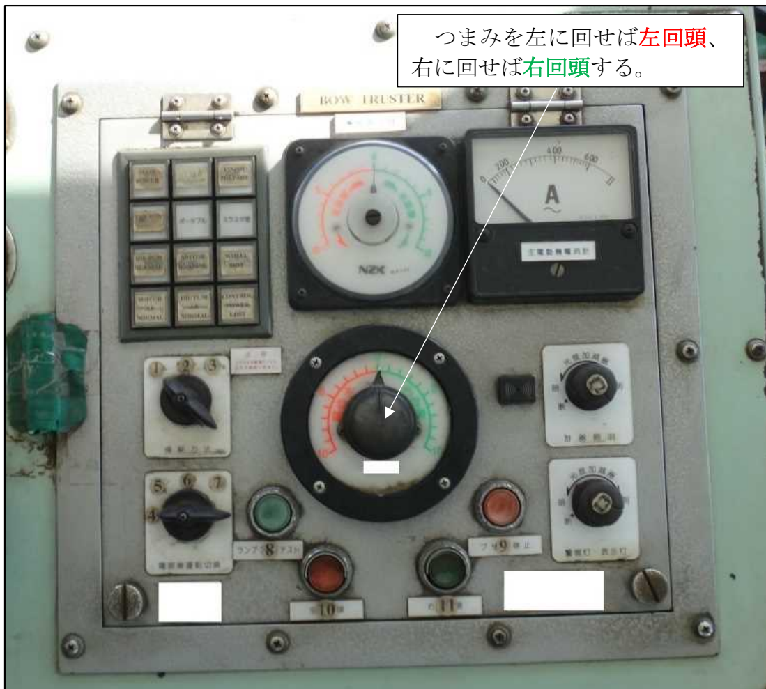
写真5 バウスラスト操作盤
