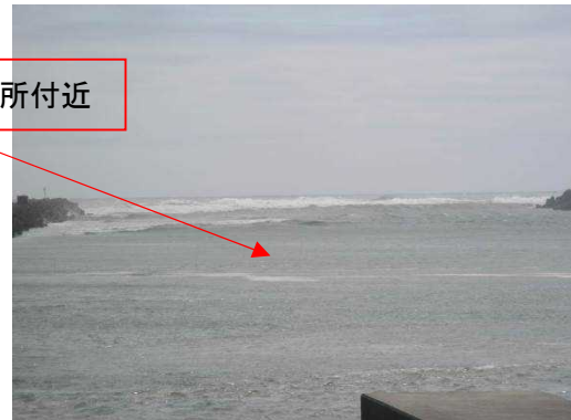
写真3 本件水路に波が入ってきた状況
