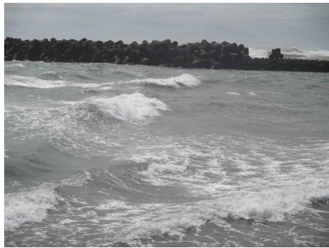
写真6 本事故発生場所付近
