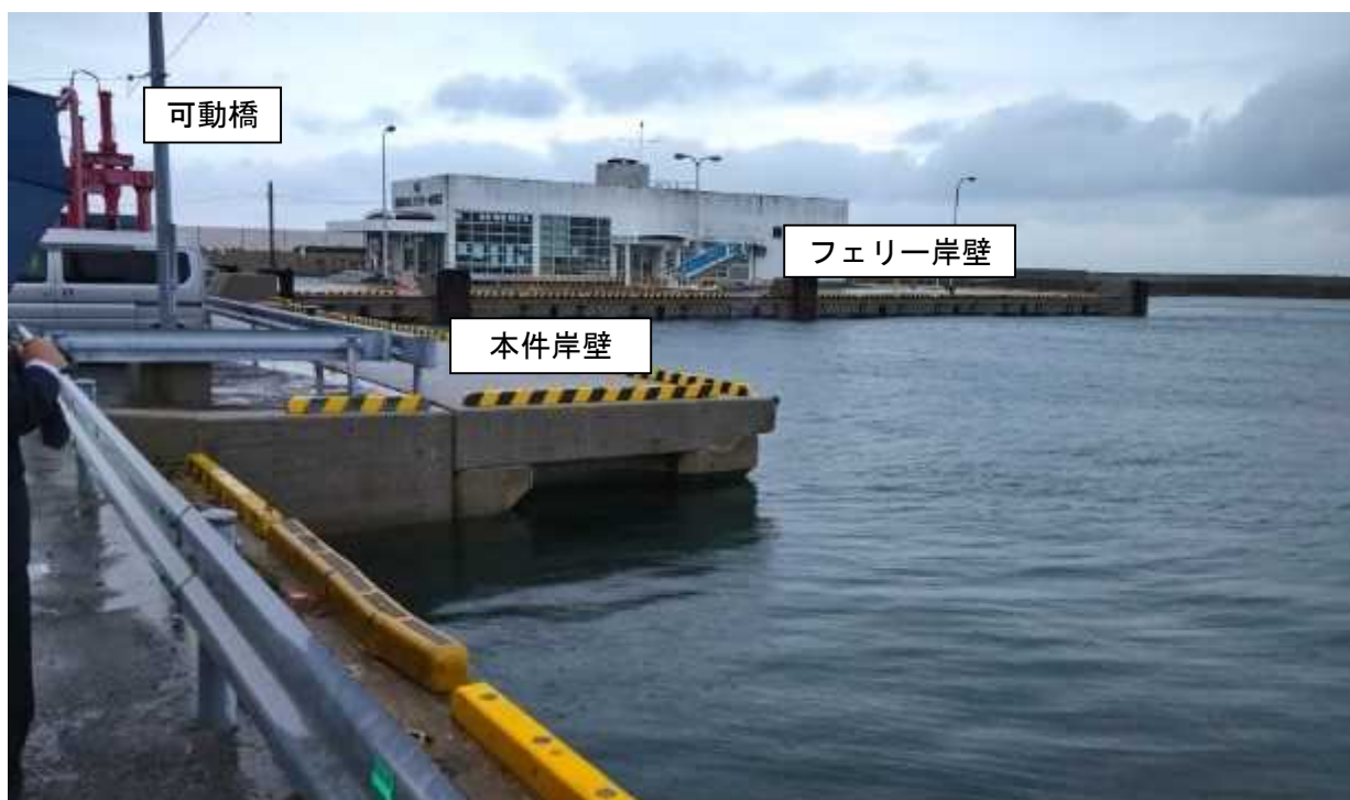
写真5 フェリー岸壁及び本件岸壁
