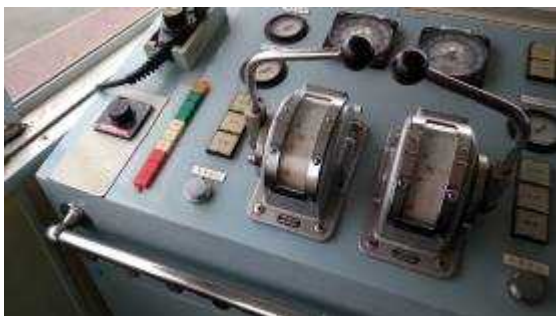
写真2 左舷操縦装置
