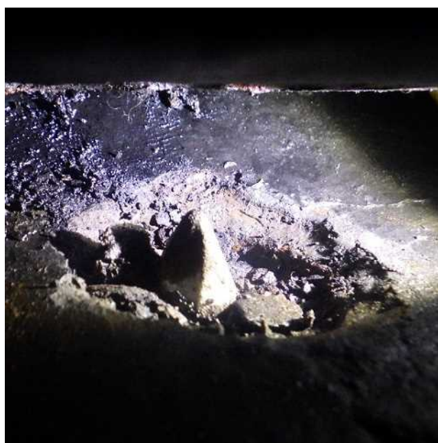
写真4 ローブボックスの破損状況
