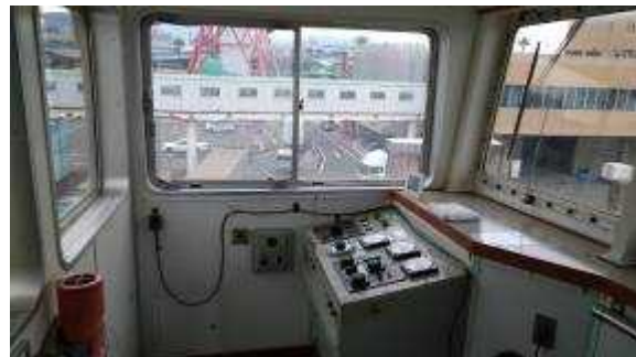
写真3 左舷遠隔操縦装置
